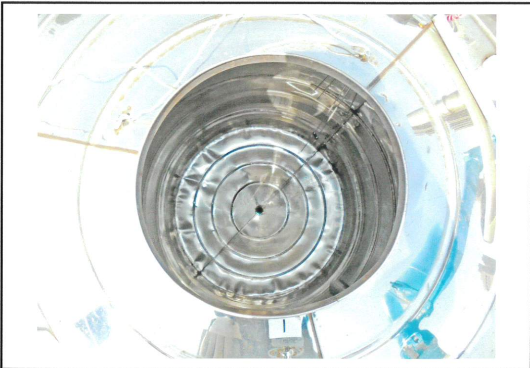
1 上水塔清洗後
