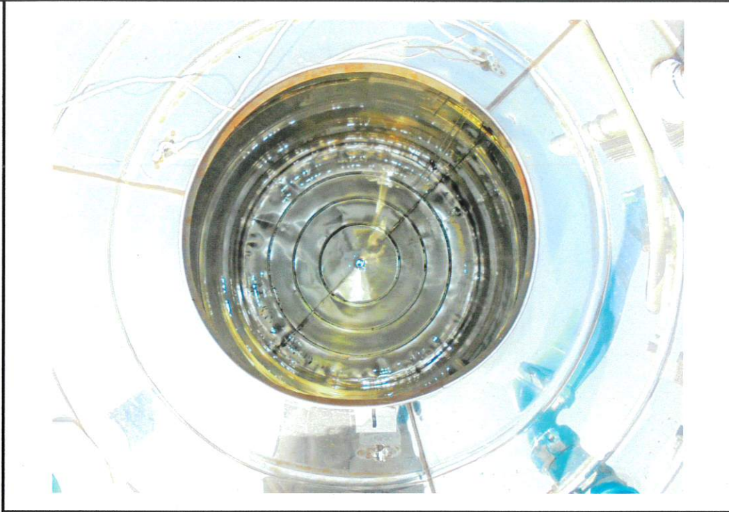
1 上水塔清洗前
