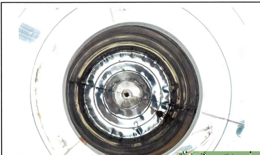
1 上水池清洗後
